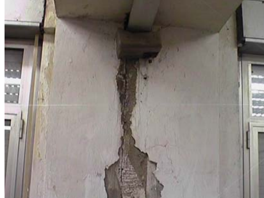
Fig. 6 – a) Deterioramento dovuto a scarsa manutenzione b) inadeguatezza dei giunti di separazione.
