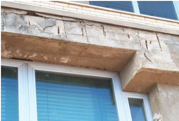
Fig. 6 – a) Deterioramento dovuto a scarsa manutenzione b) inadeguatezza dei giunti di separazione.
